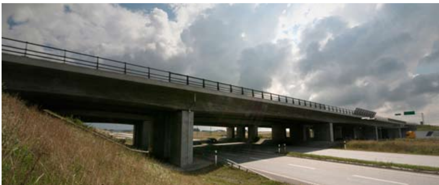
Motorvägsbroar Yttre Ringvägen, Trafikplats Petersborg, Malmö Uppdragsgivare: SVEDAB
